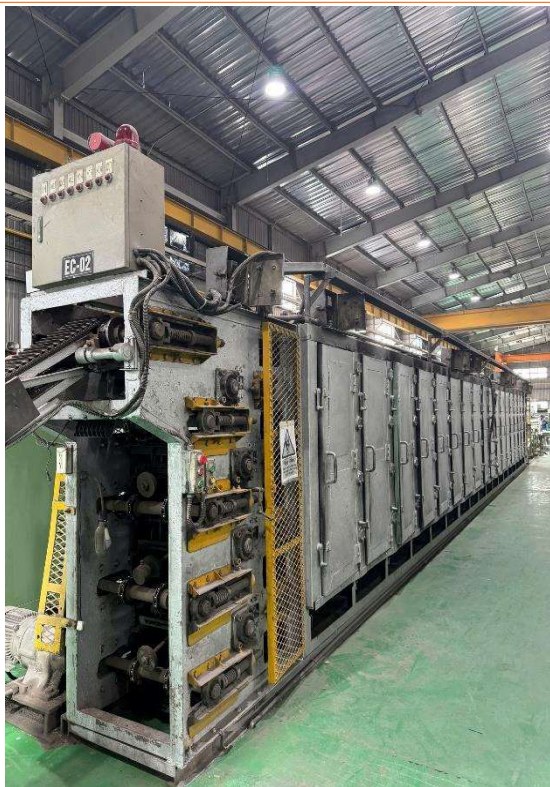
Lò sấy sơ bộ bằng gas xưởng 1
