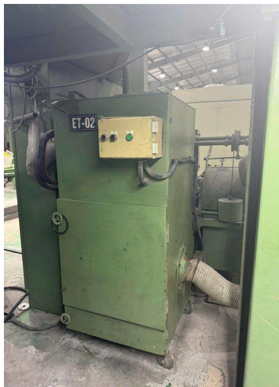
Máy thu bụi khu vực phủ bột xưởng 1
