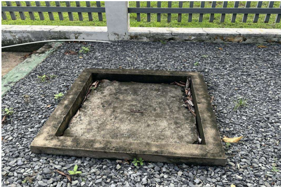
Hình 11: Hình hố ga đầu nối nước thải của cơ sở
